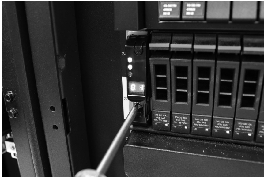
図7. ラック・キャビネットへのエンクロージャーの固定
